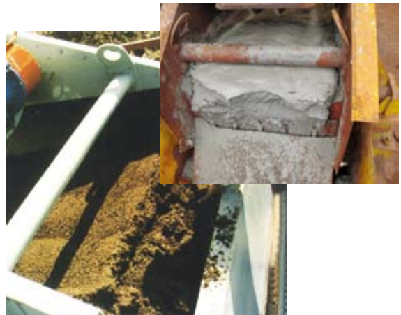
鑫海多频脱水筛使用现场 Xinhai dewatering application
